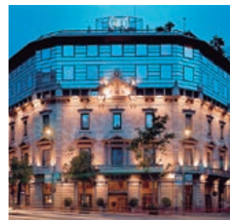
Přestavba hotelu. Hotel Claris 5*. Barcelona, Španělsko. ECOi
